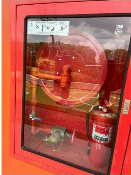
ภาพที่ 30 ถังดับเพลิงและตู้เก็บอุปกรณ์ดับเพลิง
